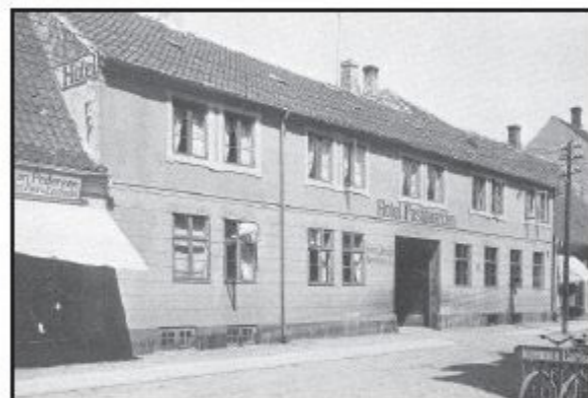
Postgården med pudset facade
